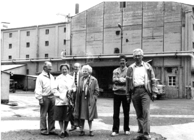
Rózsa Deutsch (2. v. l.) und Nora Stark (4. v. l.) besuchten am 07. September 1988 das ehemalige Gelände der Firma Max Gehrt. 241 Im Hintergrund ist ein Teil der Fabrik zu sehen, in der sie Zwangsarbeit leisten mussten.
